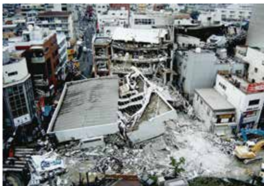
震災によりコープこうべ本部も倒壊
